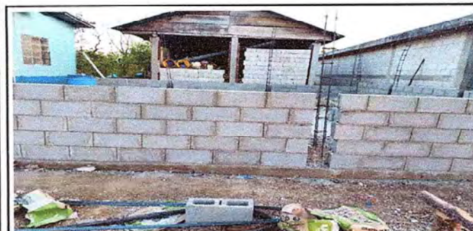
Foto 5: Continuación de pared
