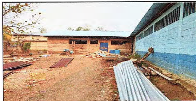
Foto 4: Cambio de techo de cocina
