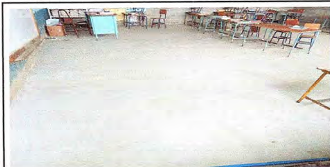
Foto 3: Sustitución de piso
