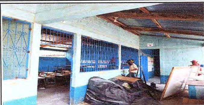
Foto 1: Cambio de Puerta
