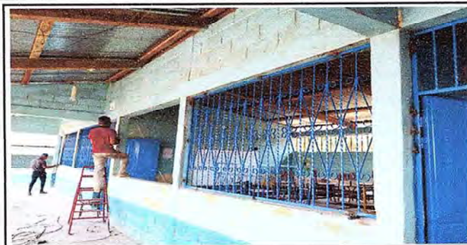
Foto 2: Cambio de balcones
